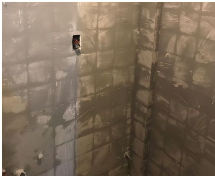
Primera mano de Base Niveladora
